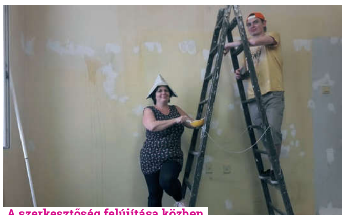
A szerkesztőség felújítása közben
